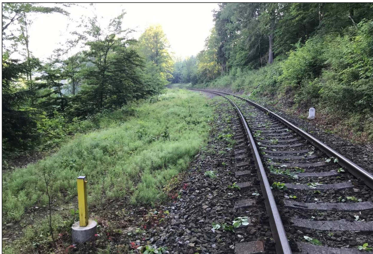
Obr. 2: Geodetické monitorovací body (km 78,700)
